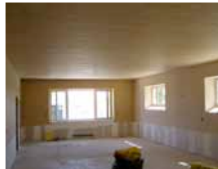
La salle encore en travaux...
